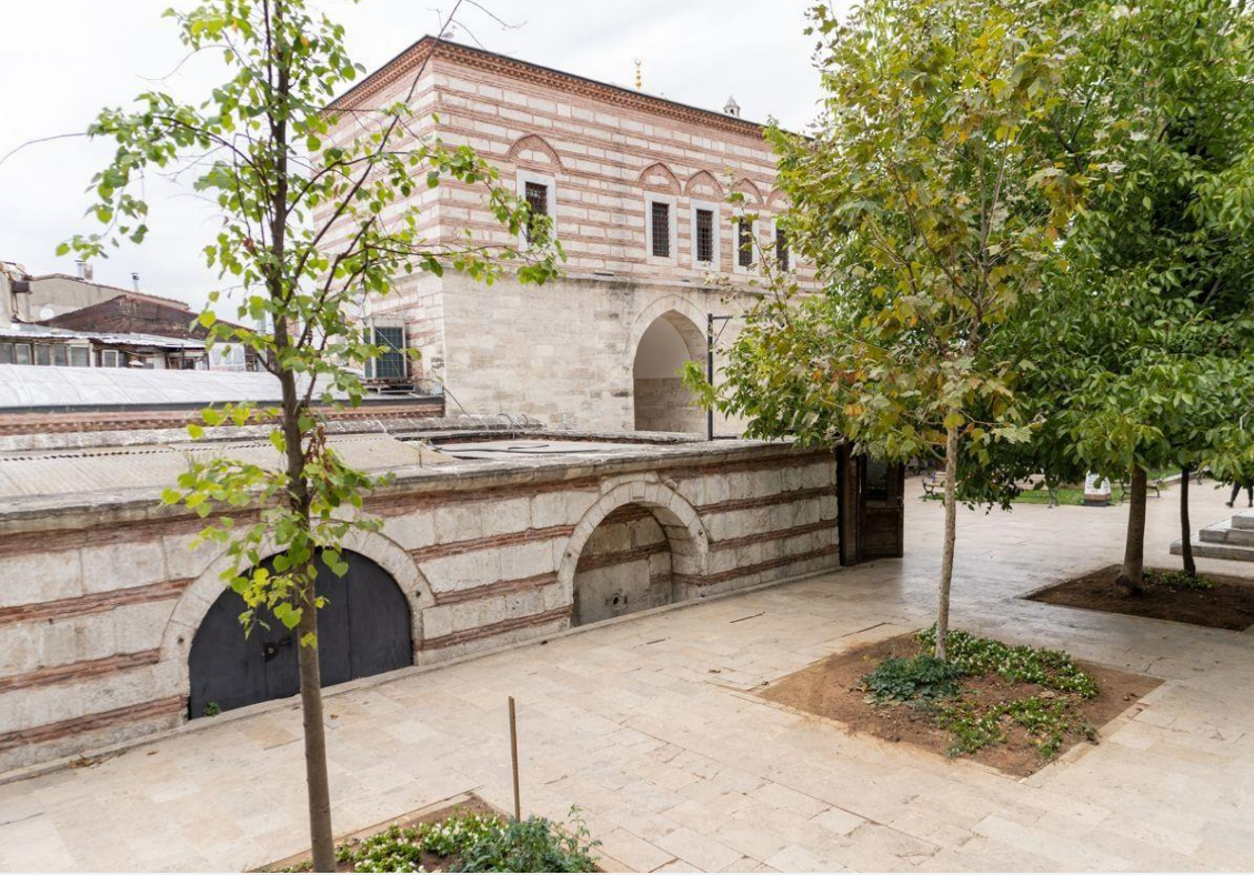
Yeni Valide Camii'nin dış avlu kapısı üzerinde bulunan ve XVI. yüzyılda Sıbyan Mektebi olarak kullanılan bina – Üsküdar/İstanbul
